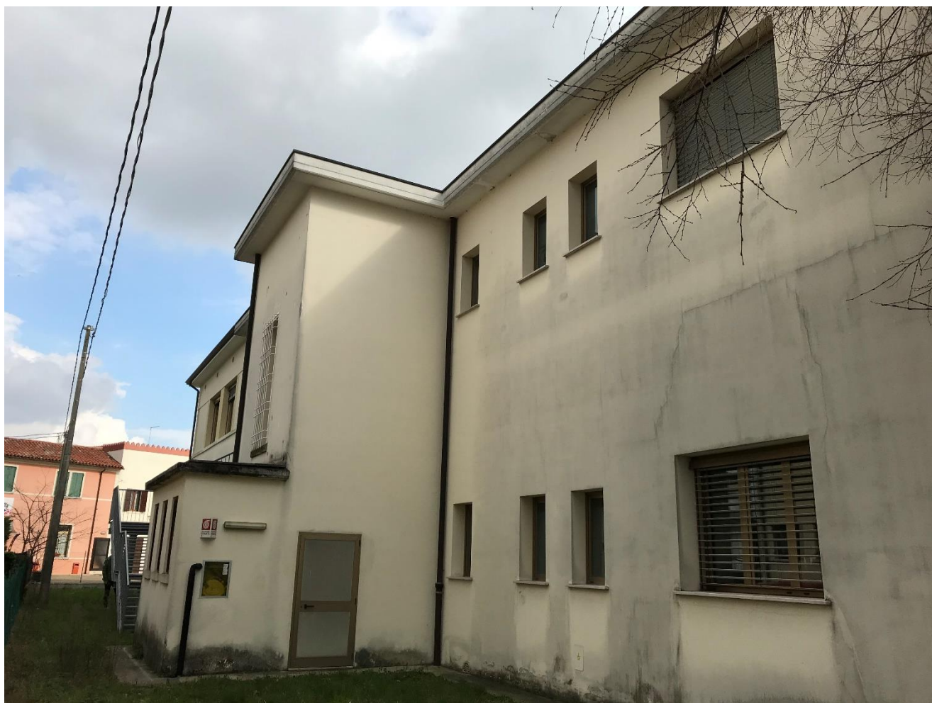
Figura 6: Prospetto nord, porzione vecchia
