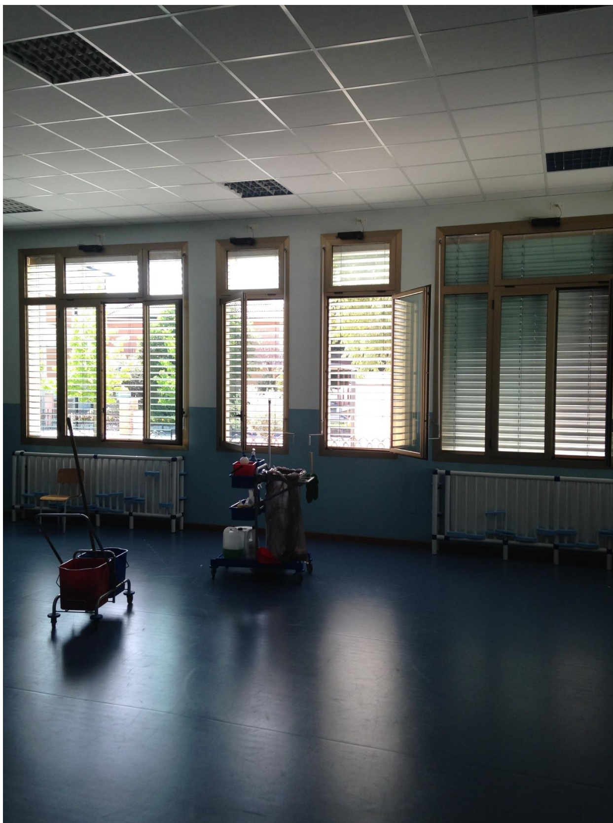
Figura 8: Vista interna della palestra, porzione ampliamento
