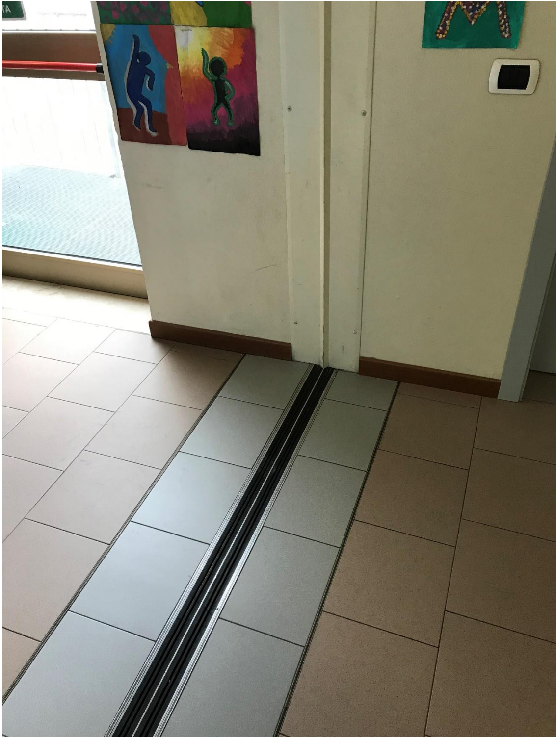
Figura 12: Particolare del giunto sismico presente tra le due porzioni di edificio
