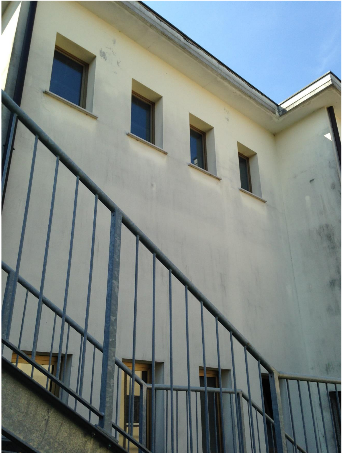
Figura 5: Vista del prospetto nord, corpo bagni sopra la centrale termica
