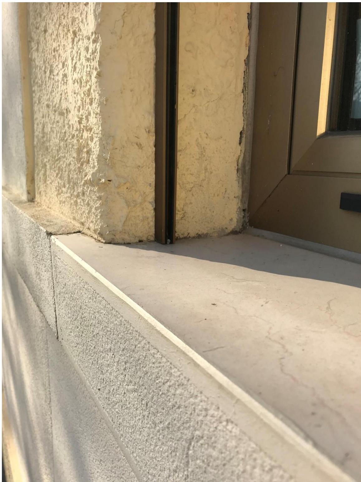
Figura 16: Vista di dettaglio della spalletta della finestra, parte vecchia
