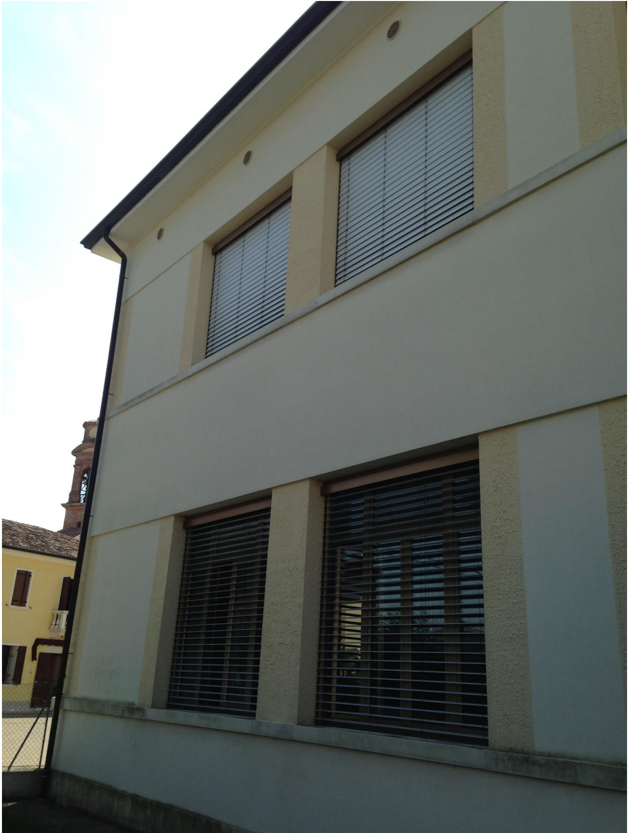
Figura 4: Vista del prospetto nord, porzione ampliamento
