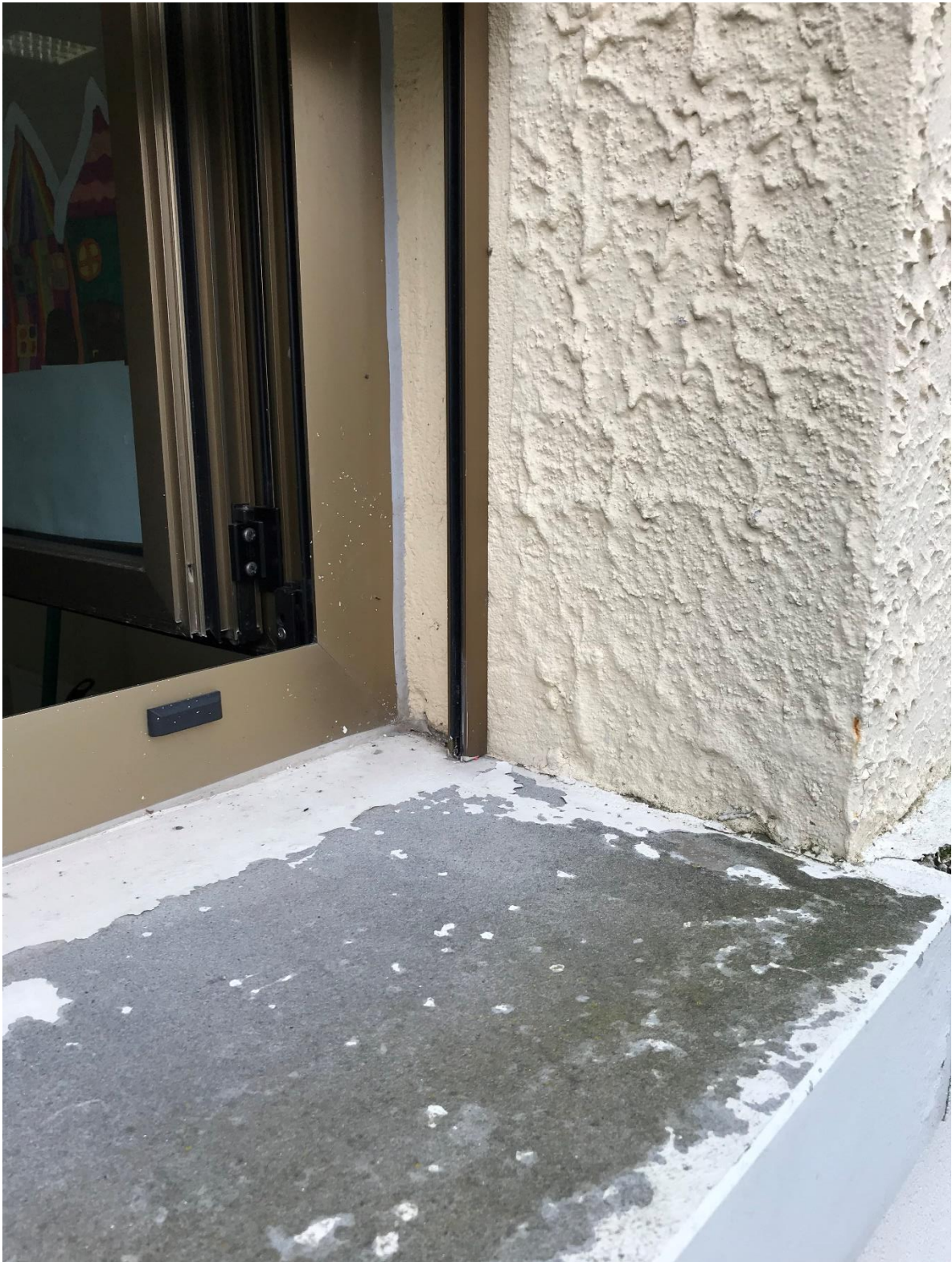
Figura 15: Vista di dettaglio della spalletta della finestra, parte ampliamento
