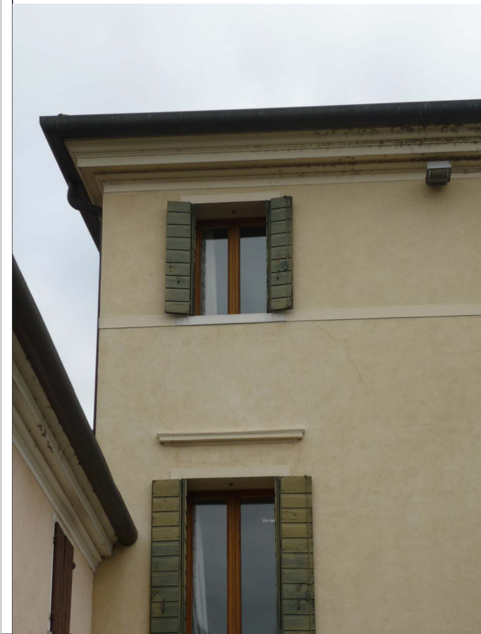
FOTOGRAFIA 1 DETTAGLIO CORNICE IN COPERTURA
