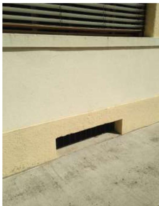
Figure 4 e 5: Vista della facciata posteriore edificio e particolare delle bocchette di aerazione dell'intercapedine sotto il pavimento
