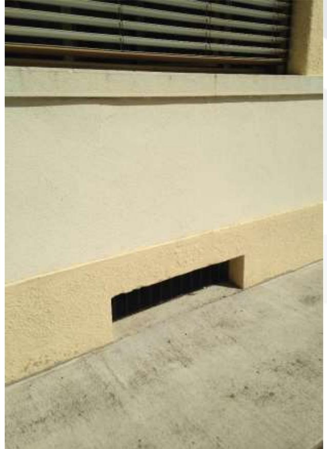
Figure 4 e 5: Vista della facciata posteriore edificio e particolare delle bocchette di aerazione dell'intercapedine sotto il pavimento
