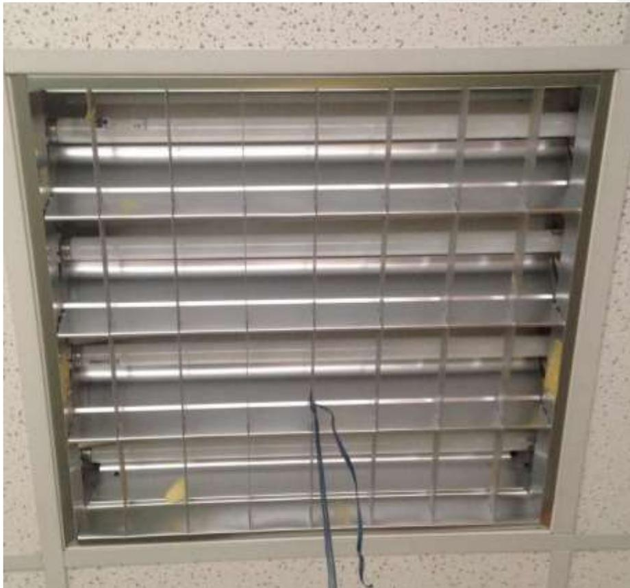
Figure 8: Plafoniera a 4 tubi da 60 cm attacco T8 presente nel controsoffitto delle aule
