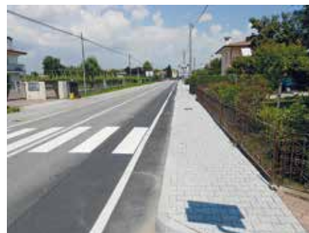
Nuovo marciapiede via Croce
