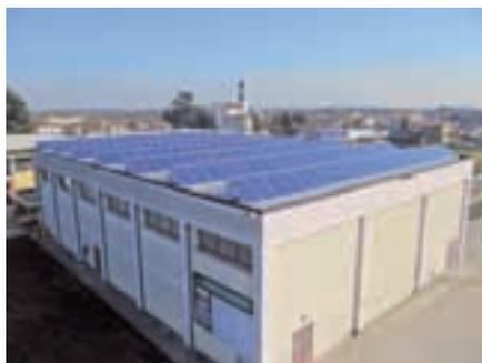
L'impianto produrrà 39 Kw, è stato realizzato nei mesi di novembre-dicembre sopra il tetto della palestra. Nell'occasione è stato isolato anche il tetto dell'edificio, perciò il beneficio, in termini di risparmio energetico, sarà duplice.
